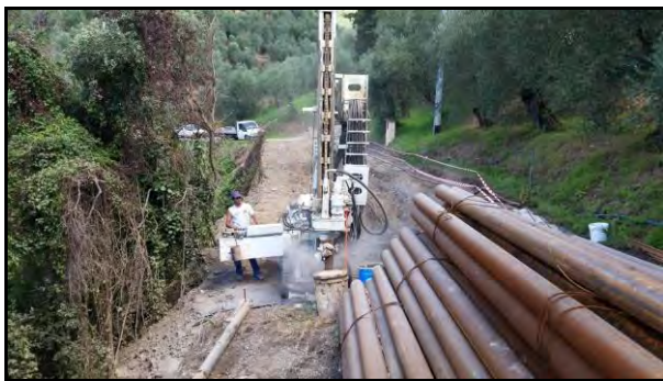
Realizzazione di micropali
