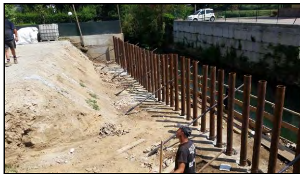
Realizzazione di berlinesi con tiranti passivi
